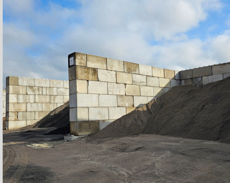
Box de áridos, Planta San Fernando, Buenos Aires
